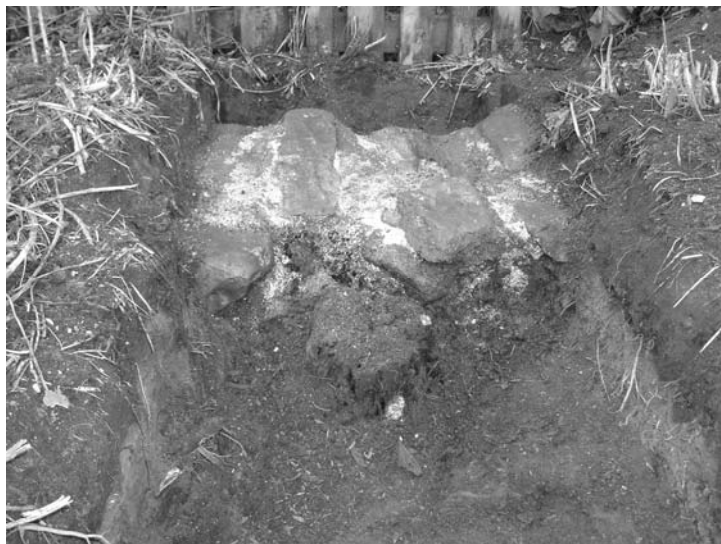
Рис. 2. Фрагмент бутового фундамента. Фотография 2003 г.
