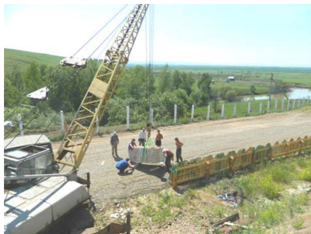
Рис. 5. Вывоз монолита № 1 с помощью автокрана
