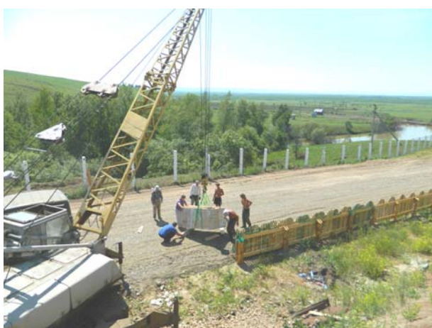
Рис. 5. Вывоз монолита № 1 с помощью автокрана
